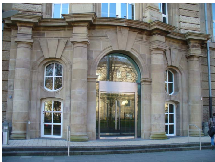
GWZ, Gebäude Mainzer Str. 5, Eingang Ubierring
