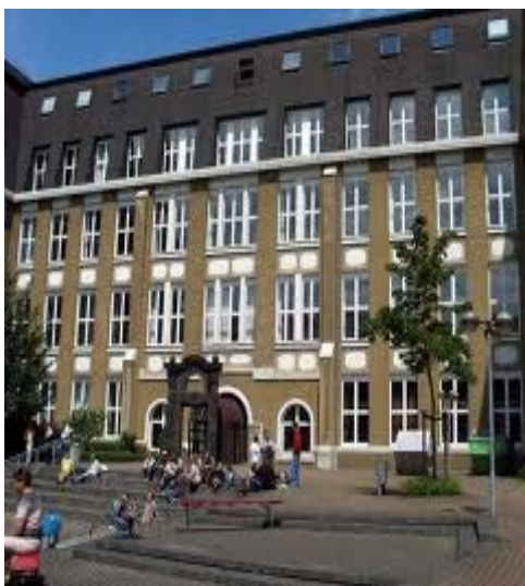
GWZ, Gebäude Mainzer Str. 5, Eingang über Innenhof
